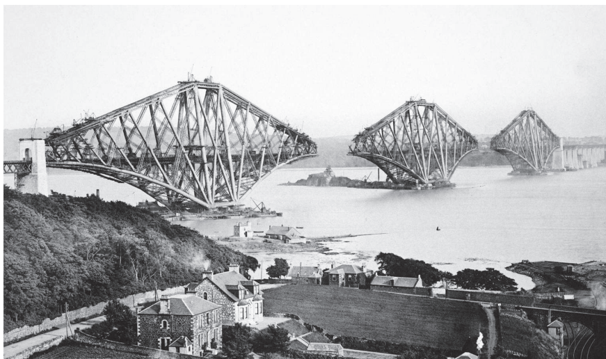
Il ponte prima dell'inserimento della trave reticolare centrale
