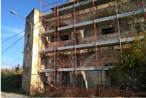
a) Edificio Storico
